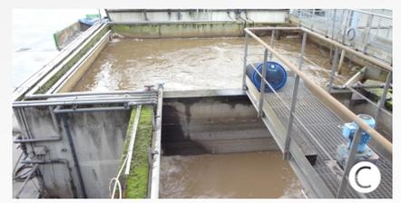
Les eaux usées chaudes sont collectées avec des polluants solvatés et colloïdaux (graisse, sable, poussière) et des débris plus importants à l'aide de caniveaux **A**. Elles passent ensuite par un séparateur d'huile et de boues **B** puis par un flocculateur **C**.
